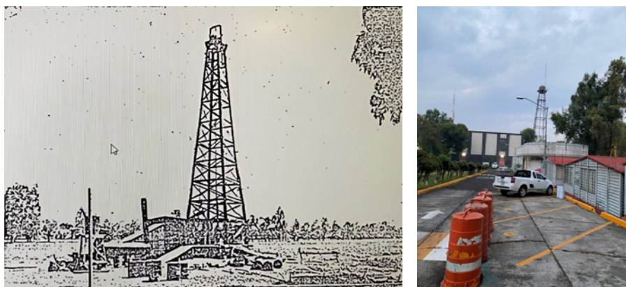
Imagen 2. Izquierda: Fotografía publicada en el periódico. El pie de foto señala: “Pozo de Xotepingo. Perforación con barrena de 1.20 metros de diámetro por cimentación a 133 metros de profundidad”. Fuente: Jueves de Excelsior , noviembre 22, 1934. Foto: Beatriz Hernández. Derecha: Fotografía actual de la Planta de Bombeo. Al fondo, se conserva la torre de perforación de 1934. Foto: Aurea Maya.
