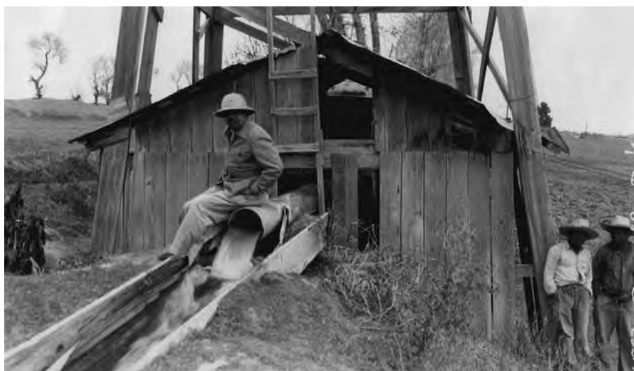
Figura 5.2. Un ingeniero sentado en una tubería a través de la cual el agua del río Nazas, extraída mediante una bomba, desemboca en el canal de Guadalupe. Dos campesinos están de pie, a poca distancia, a su izquierda. Cortesía del Archivo Histórico del Agua, Ciudad de México, Noria extrayendo agua del río Nazas conducida por el canal de Guadalupe , 1942, San Pedro, Coahuila, CONAGUA-AHA, Fondo Aprovechamientos Superficiales, caja 3067, expediente 42425, 30.
