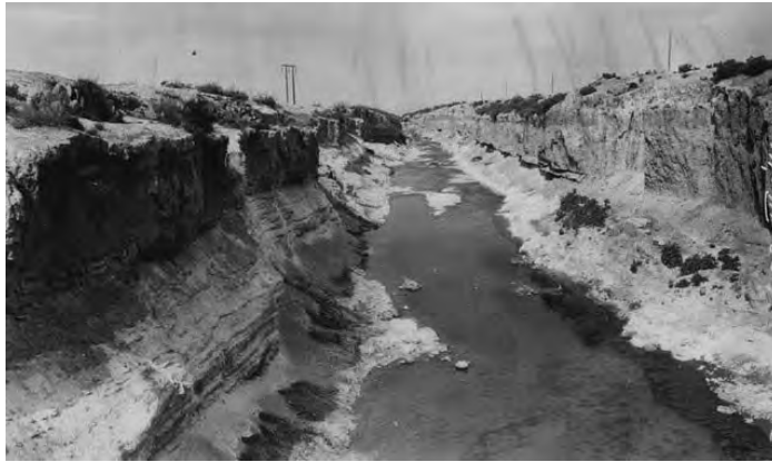
Figura 2.1. El Canal Tlahualilo, sin pavimentar y erosionado. Cortesía del Archivo Histórico del Agua. Vista mostrando la erosión del canal de Tlahualilo cerca de Bermejillo, 1941, Lerdo, Durango. CONAGUA-AHA, Fondo Aprovechamientos Superficiales, caja 3067, expediente 42425, 44.
