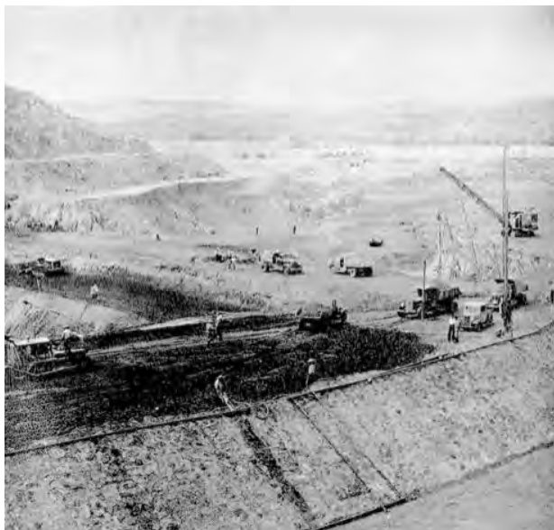
Figura 4.3. La presa El Palmito en construcción. Fuente: Comisión Nacional de Irrigación, La obra de la Comisión Nacional de Irrigación , México, CNI, 1940, p. 48.
