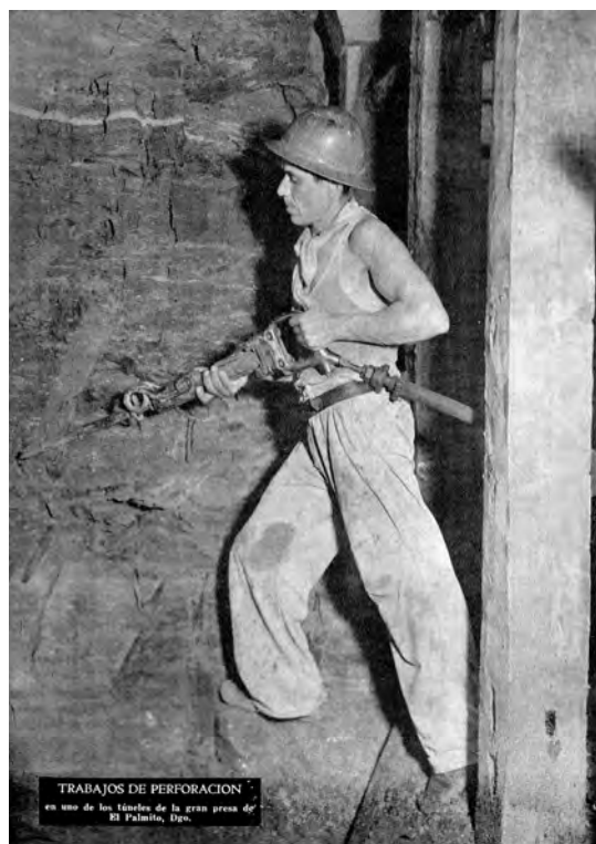
Figura 4.1. Un trabajador excavando dentro de un túnel de derivación en el sitio de la presa El Palmito. Fuente: Comisión Nacional de Irrigación, La obra de la Comisión Nacional de Irrigación , México, CNI, 1940, p. 149.
