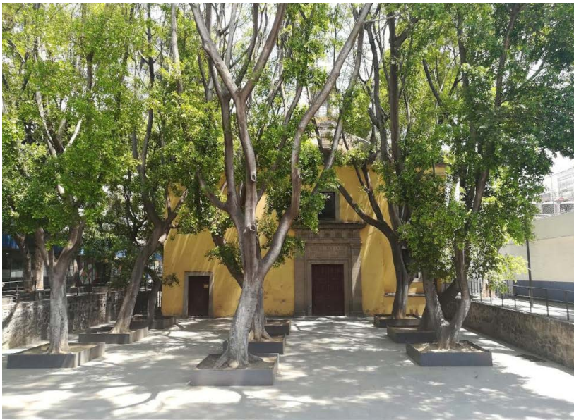
Plazoleta de la Capilla de Santa María Magdalena/Plaza de las Recogidas. Foto: MEVA.
