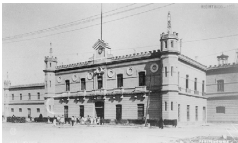
Fachada de la penitenciaría federal de Lecumberri.
